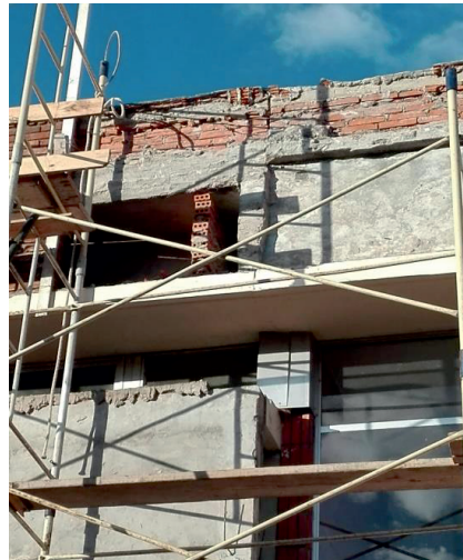
Imagen 6 Falta apoyo entre losas, y falla de junta
