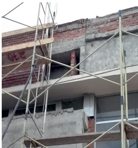
Imagen 17 Juntas y falta grampas Oeste.
