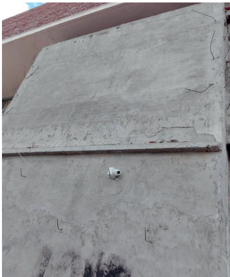
Imagen 1 Insuficientes grampas amure - Este
