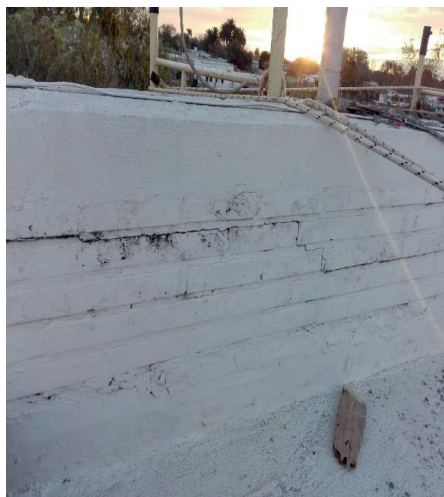
Imagen 13 Fisuras horizontales pretil Este.
