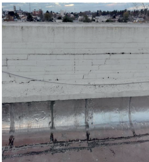
Imagen 15 Fisuras horizontales pretil Este
