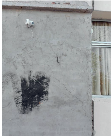
Imagen 2 Fisuración diagonal – baños Este
