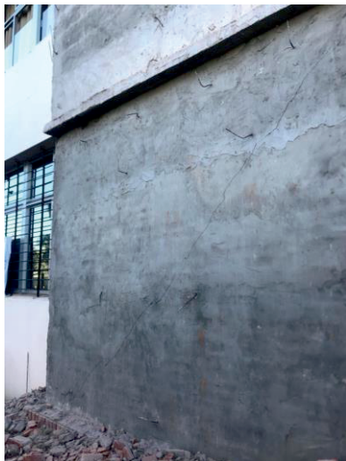
Exteriores – fisuras en sector servicios
